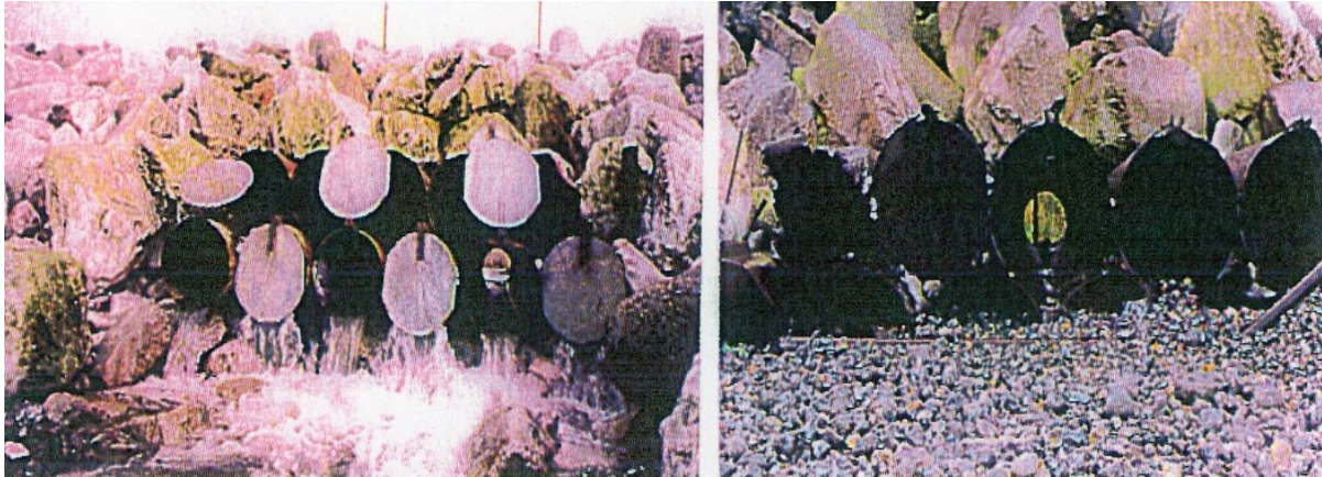
"orgues de Staline" de CRIEL sur MER avec (photo de gauche) et sans clapets (photo de droite) source Mairie de CRIEL sur MER
