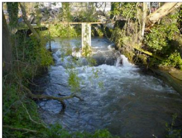
Ancien vannage de décharge amont
