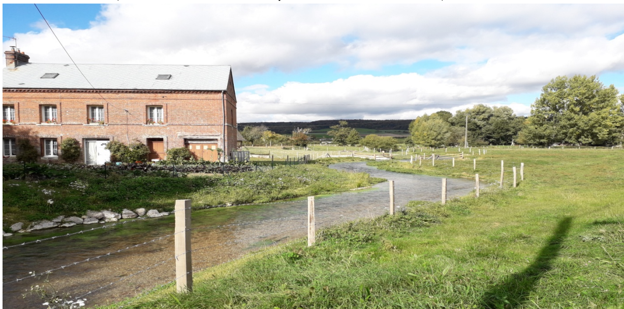
exemple de restauration de la continuité écologique au moulin d'ESTOT
